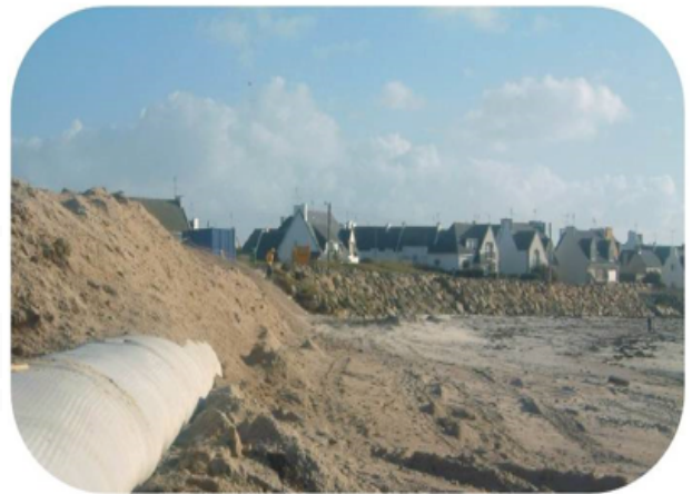
Cordon dunaire de la plage de la Grève Blanche – Le Guilvinec Février 2004 – Phase de travaux
